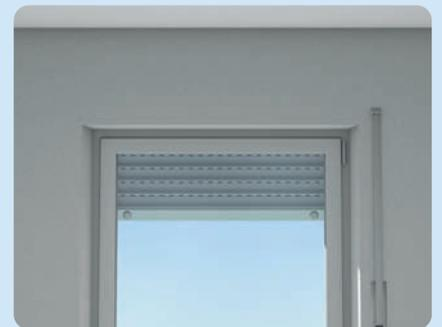
unsichtbar. Außerdem kann durch den Kastenüberstand ein Einlasswickler problemlos in das Mauerwerk integriert werden.
